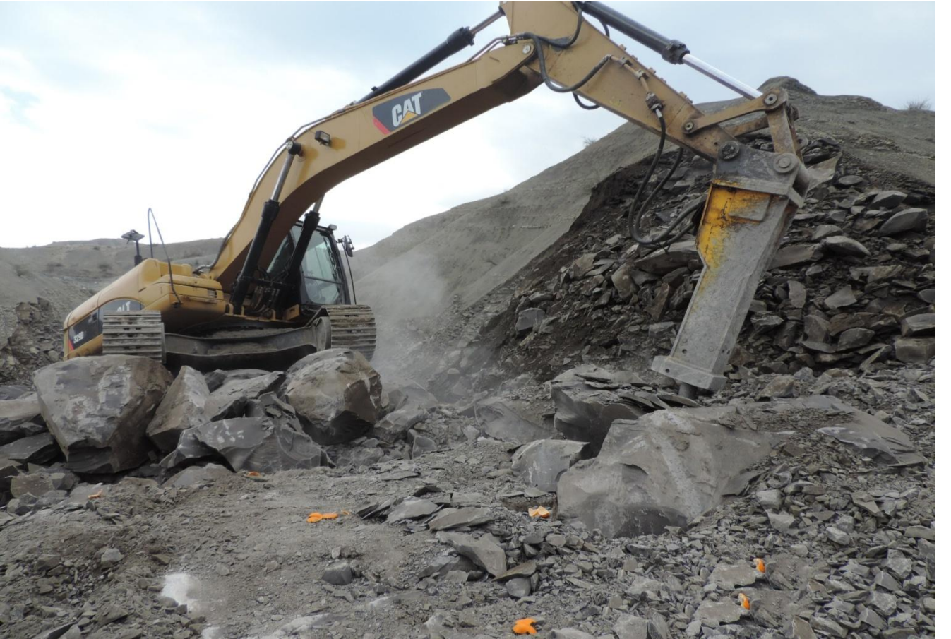
NASRAVAN KAPLICA YENİ YOL AÇILMASI
