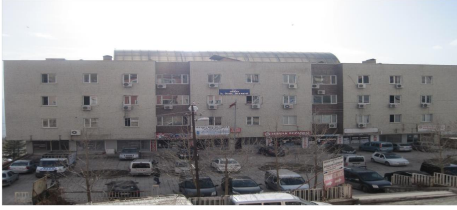
Şırnak İl Özel İdaresi Hizmet Binası
