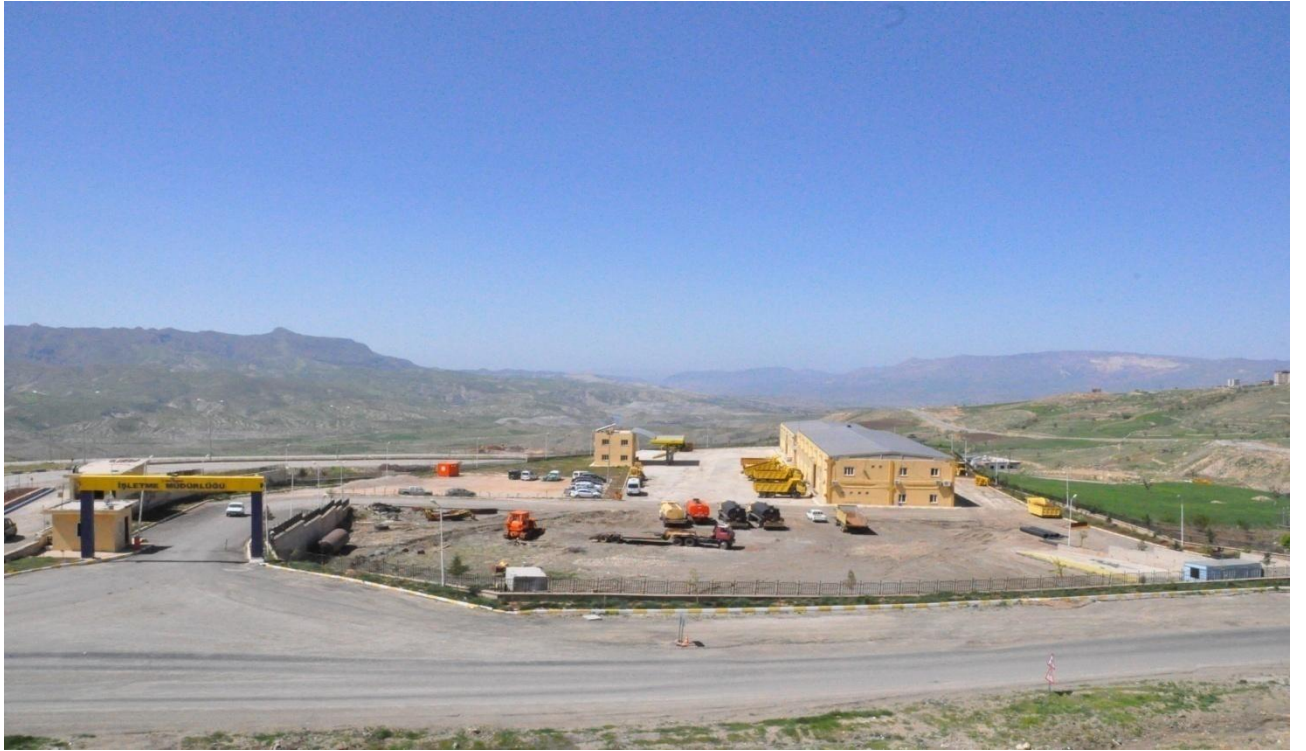
İşletme Müdürlüğü Hizmet Binası
