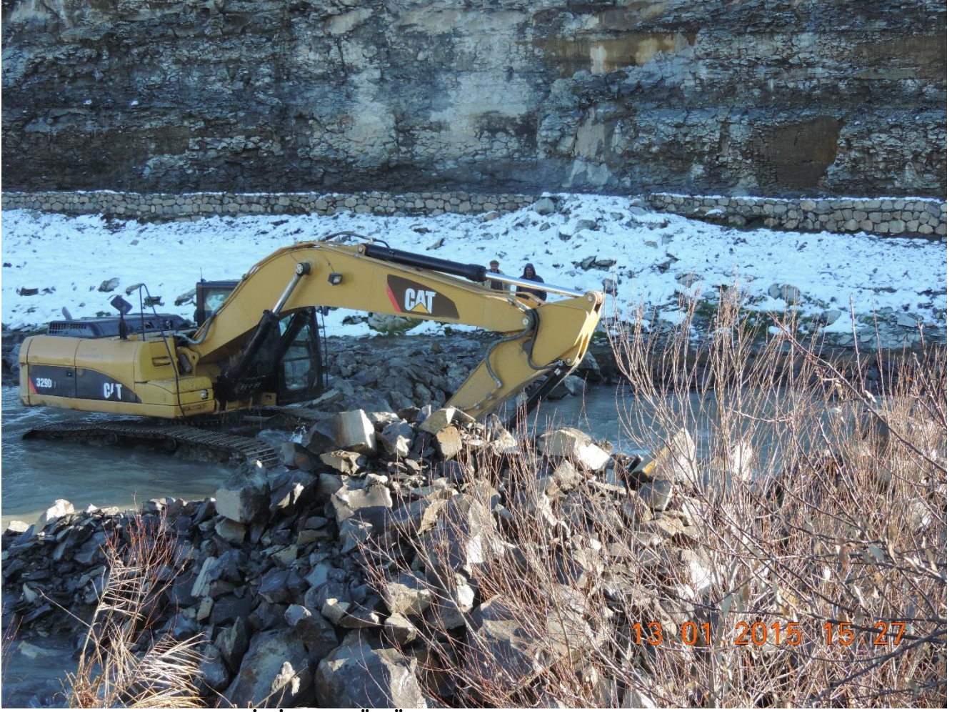
İKİZCE KÖYÜ DERE ISLAHI ÇALIŞMASI
