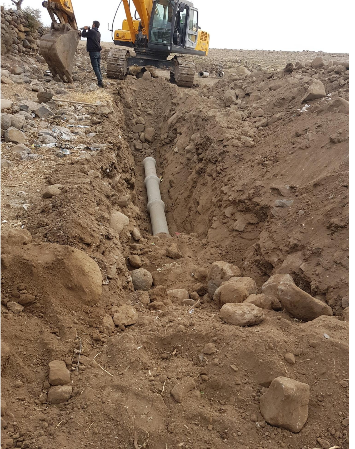
İDİL AKSOY KANALİZASYON YAPIM İŞİ
