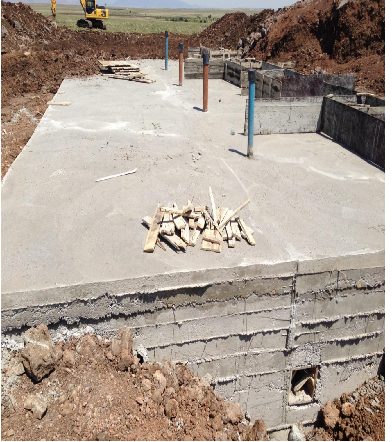
İDİL ALAKAMIŞ KANALİZASYON YAPIM İŞİ
