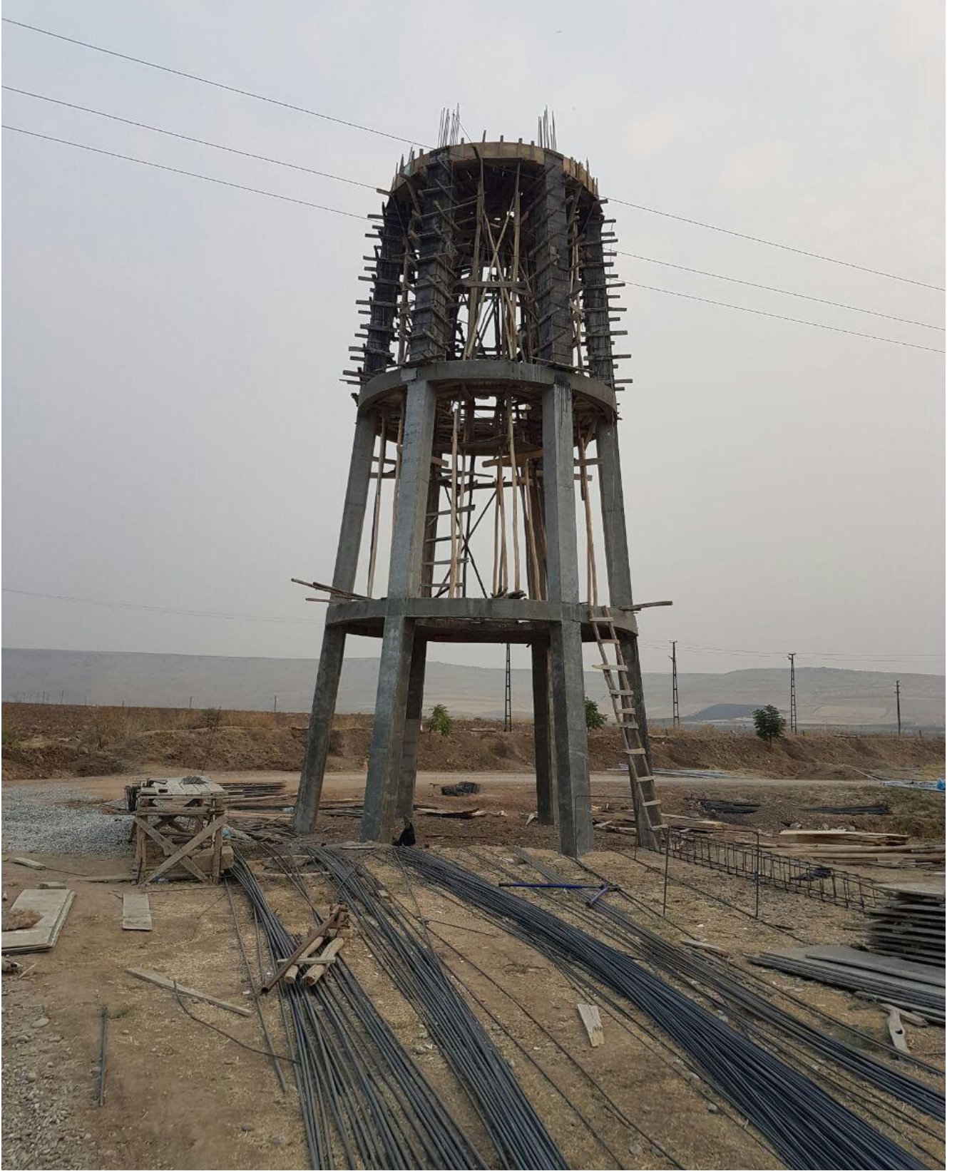
İDİL TEPEKÖY İÇME SUYU TESİSİ YAPIM İŞİ
