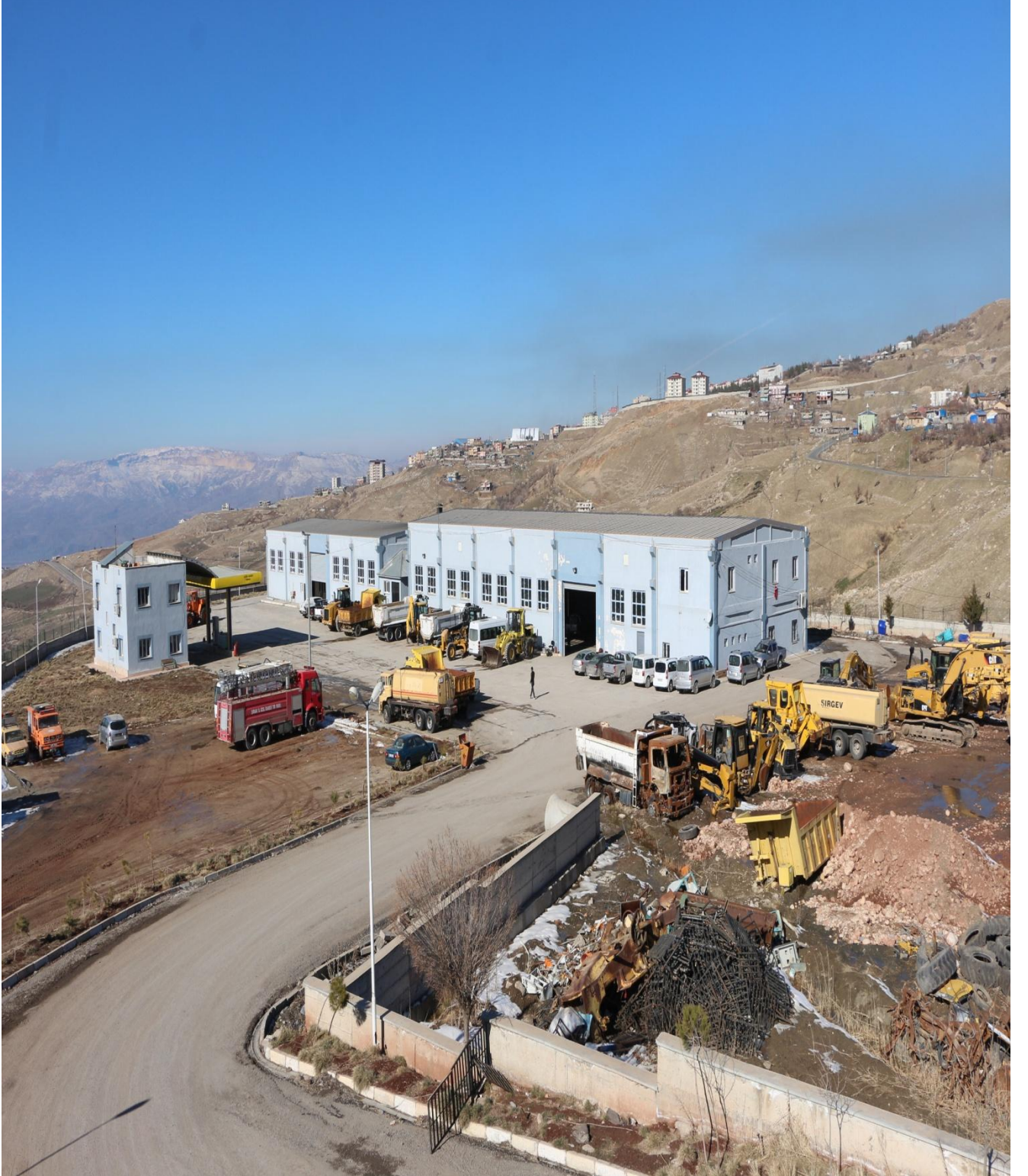
İşletme Müdürlüğü Hizmet Binası
