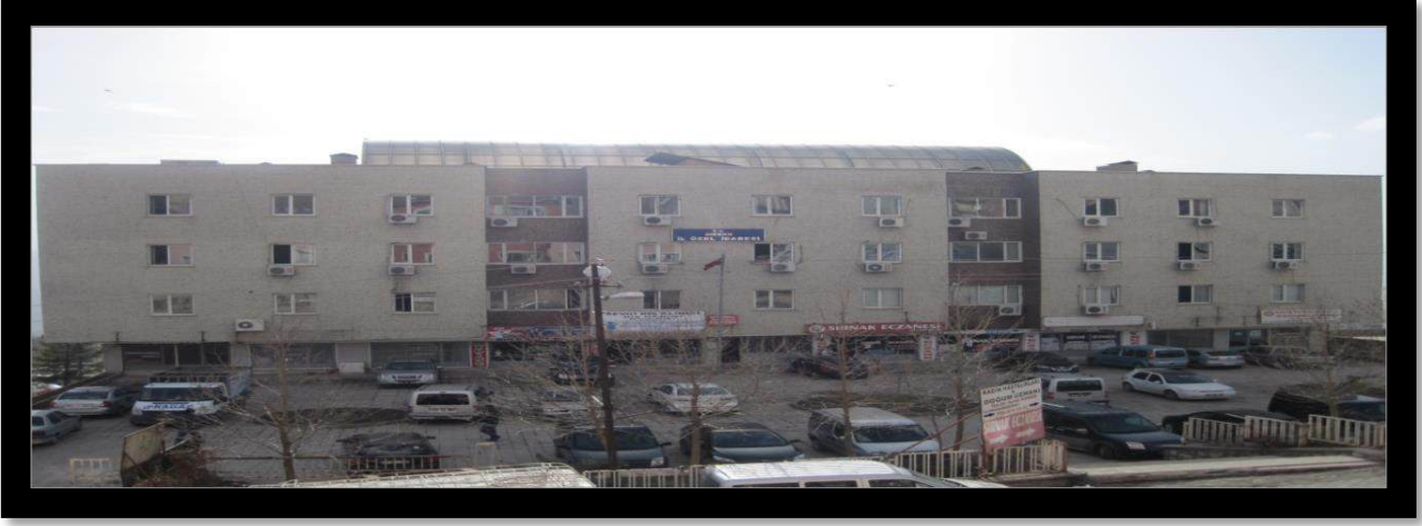
Şırnak İl Özel İdaresi Hizmet Binası
