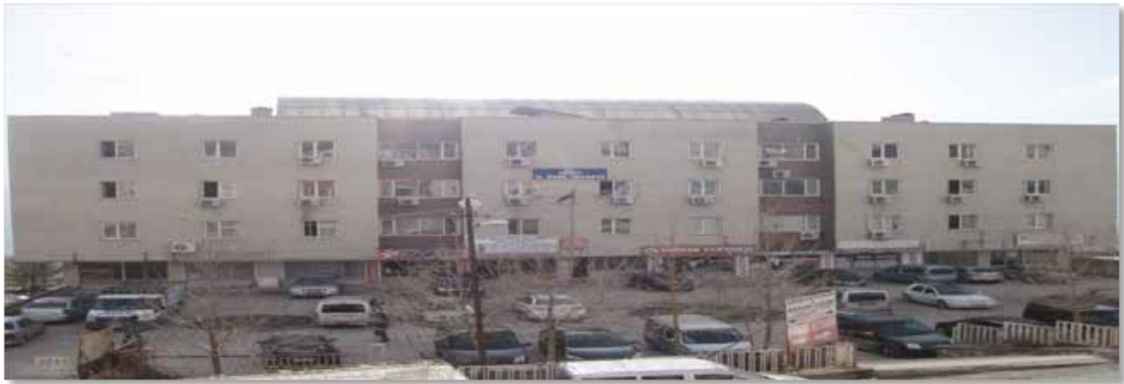
Şırnak İl Özel İdaresi Hizmet Binası
